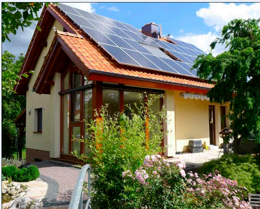
Bild 1: Südseite des Einfamilienhauses in Karow mit Ansicht der wassergekühlten PV-Module (PVT)
