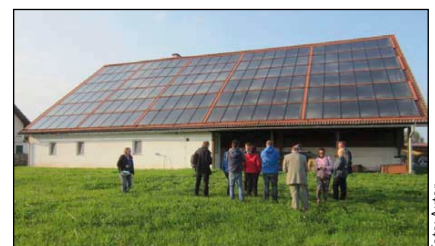
Bild 2: 320 m 2 solarthermische Kollektoren auf dem FHW Urbersdorf
