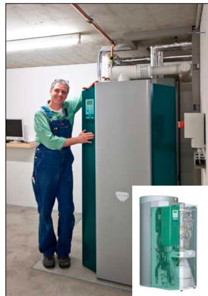
Bild 2: Der jüngere, kleine Bruder des Senertec Dachs: der Dachs Stirling SE mit 1 kW el und 5,8 kW th , aufgebaut in einer Einheit mit 18-kW-Brenner und Pufferspeicher.
