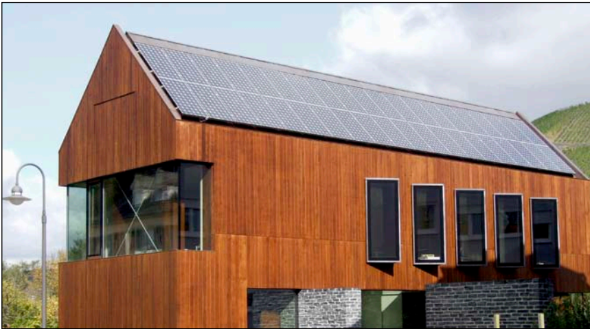
Bild 1: Das „+Energiehaus Kasel“ aus der gleichnamigen Weinbaugemeinde im Ruwertal bei Trier erzielt mit seiner 9 kWp – Photovoltaikanlage einen homogenen Gesamteindruck – eine optisch gelungene Gebäudeintegration.
