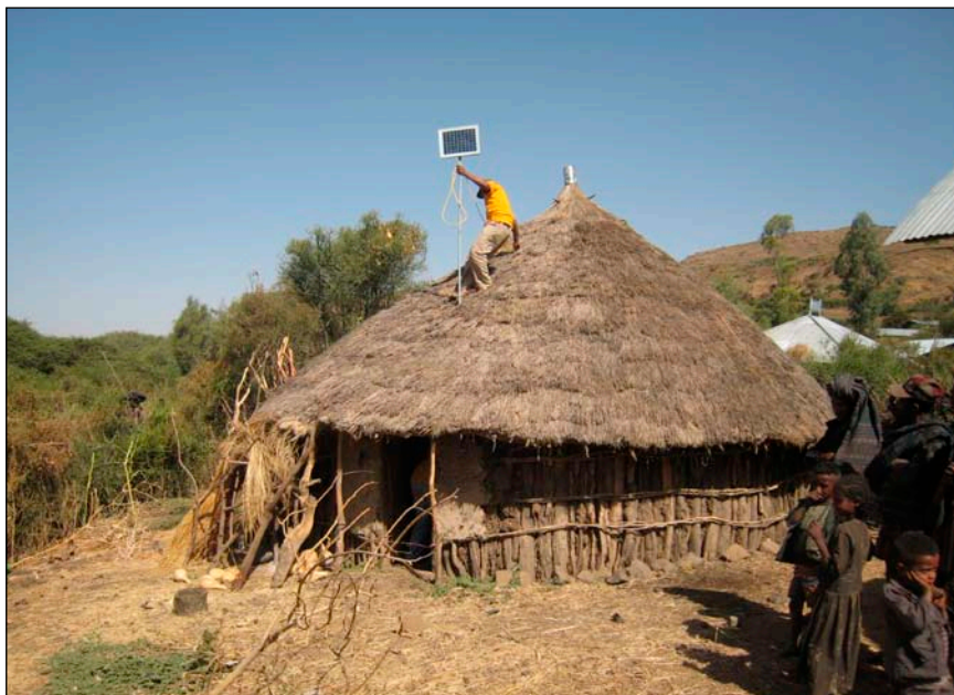
Bild 2: Die Installation der Solar-Home-Systeme auf den Runddächern ist nicht immer ganz einfach.
