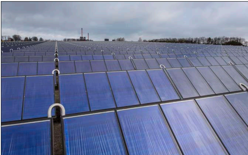
Bild 1: Das 12.000 m 2 Solarwärmesystem für das Fernwärmenetz im dänischen Grenaa. Eine typische Anlagengröße in Dänemark, die als Beispiel für Deutschland gelten kann.
