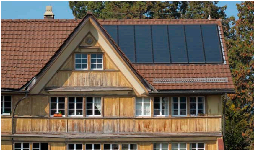
Bild 1: In der Schweiz werden Sonnenkollektoren meistens ins Dach integriert. Das macht die Anlagen teurer.
