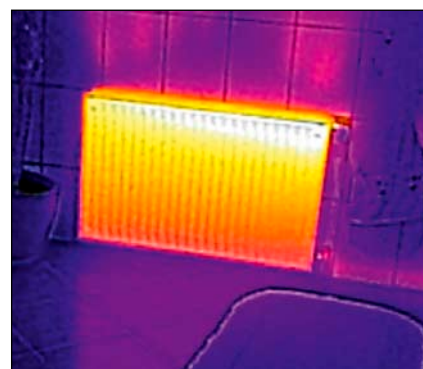
Bild 2: Das Wasser vom Heizkessel durchströmt den Heizkörper und gibt dabei seine Wärme an den Raum ab.
