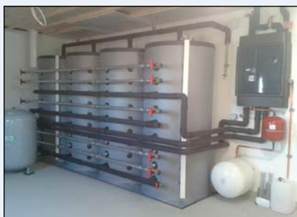
Bild 4: Pufferspeicherverschaltung nach Tichelmann
