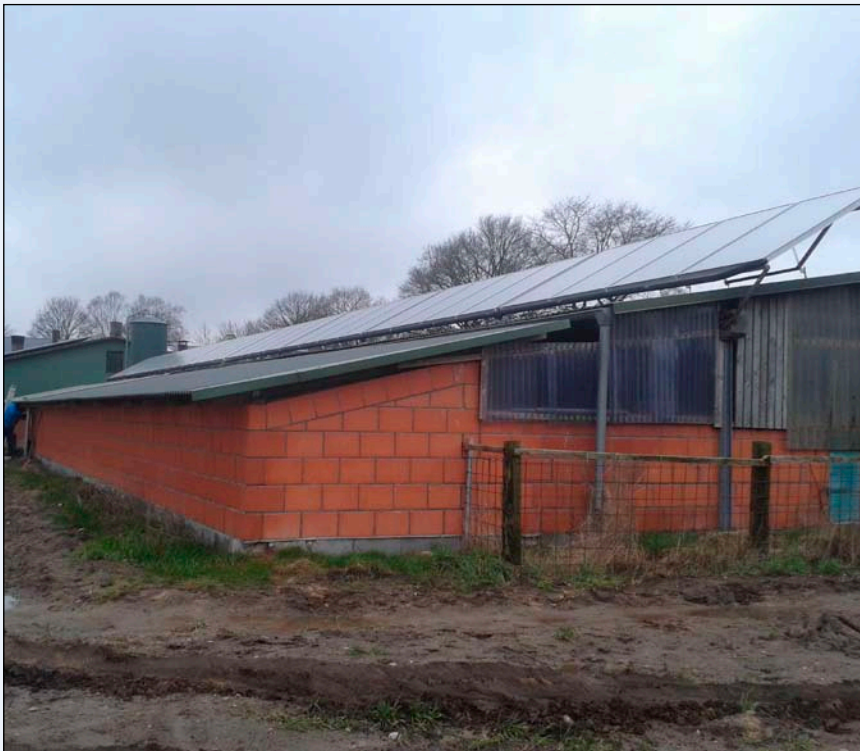
Bild 1: 86m 2 Flachkollektoren auf Ferkelstall
