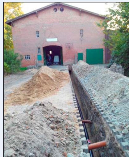
Bild 5: Erdleitung zum Ferkelnest
