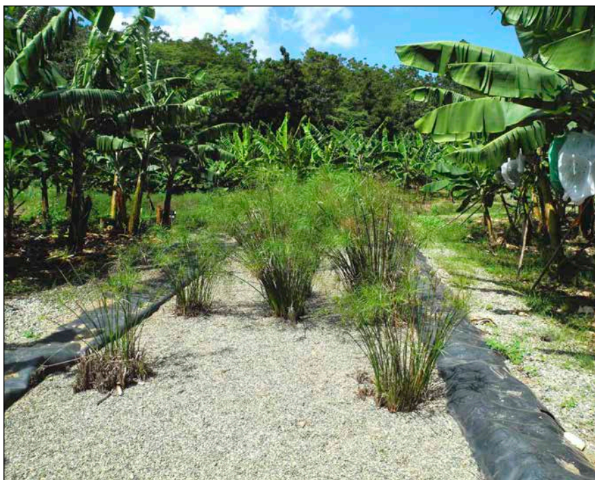
Bild 2: Abwasseraufbereitung durch eine Pflanzenkläranlage und damit ein Teilbereich der Wissensvermittlung von Umweltaspekten im Ökologischen Zentrum Cibao.
