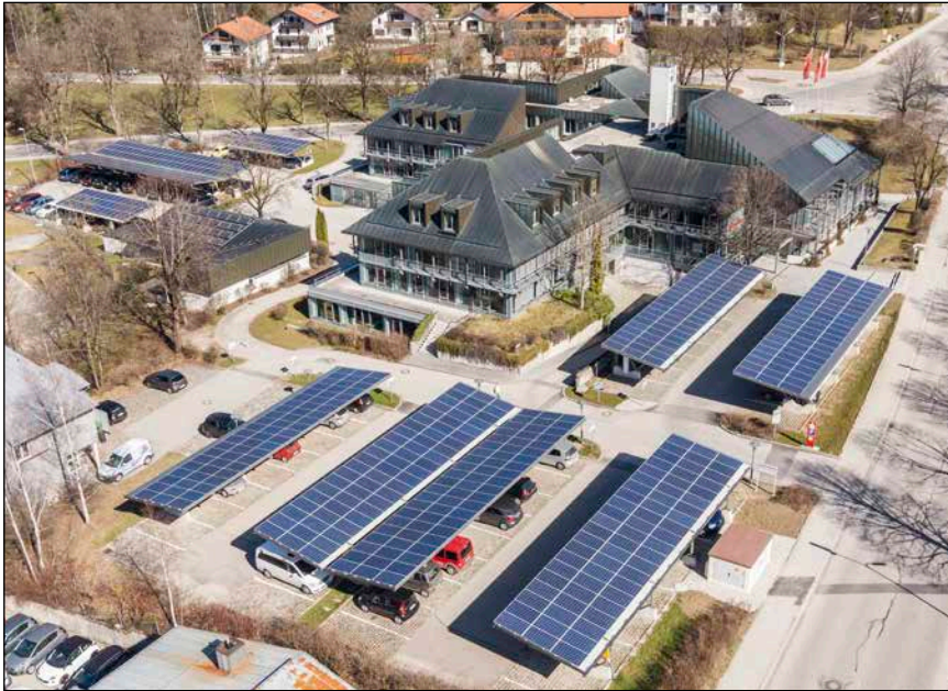
Bild 1: Solar-Carports versorgen das Sparkassen-Center in Bad Tölz
