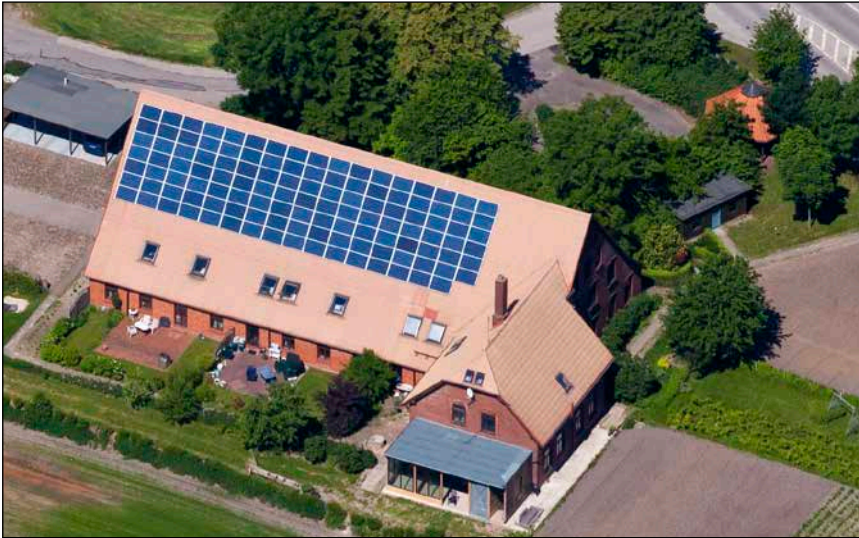
Bild 1: In diesem Mehrfamilienhaus nordwestlich von Hamburg versorgen eine 29,5 kWp PV-Anlage sowie ein hocheffizientes BHKW mit 7,5 kW elektrischer Leistung zusammen 8 Wohnungen und eine Werkstatt im Rahmen einer Lohnverstromung durch den Hauseigentümer. Der Strombezug aus dem Netz konnte mit der kombinierten Leistung beider Anlagen um 85 Prozent reduziert werden.
