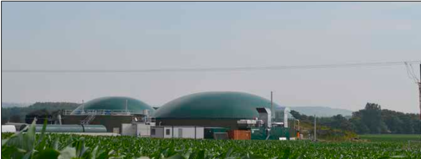
Bild 1: Tausendsassa Biogas: Eine Biogasanlage kann nicht nur organische Einsatzstoffe in Strom umwandeln. Mit der Power-to-Gas-Methode wird sie zum Speicher für Energie aus Solar- und Windkraft.
