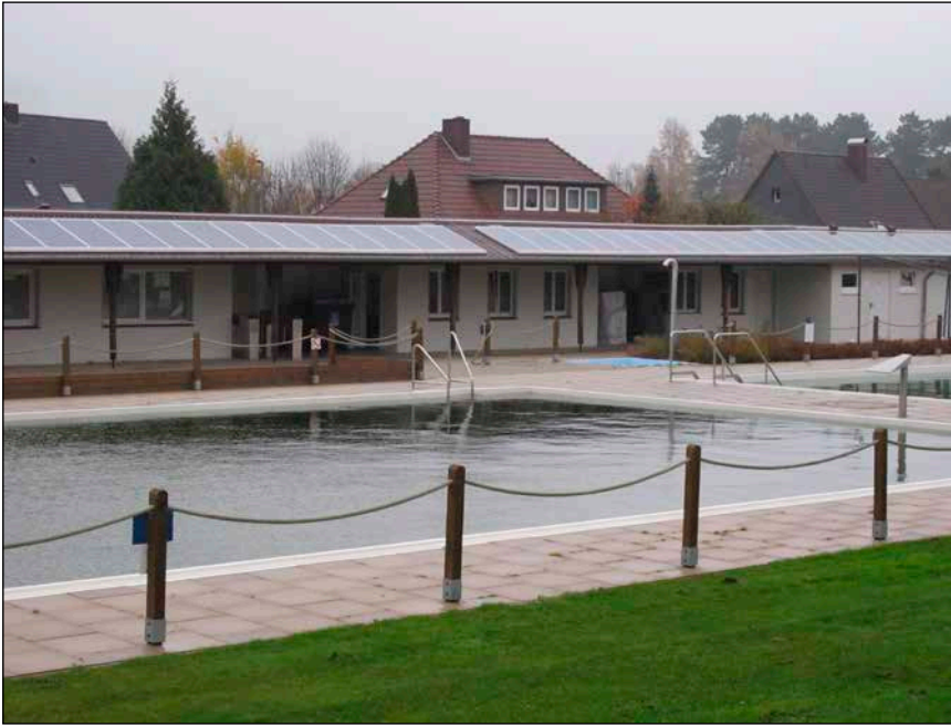
Bild 1: Dank Biogas wird das Wasser im Freibad so warm wie nie zuvor
