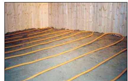
Bild 6: In dieser Abbildung kann man im Hintergrund Holzwände, die vor der eigentlichen Kellerwand mit Abstand montiert wurden. In der Lücke (Holzwand-Kellerwand) befindet sich Isoliermaterial (Glaswolle). Auf dem Boden befindet sich schon eine Schicht Erdmaterial, auf der mäanderförmig Kupferrohr verlegt wurde.
