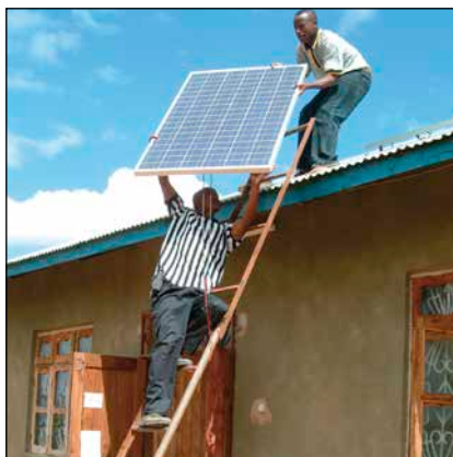
Bild 4: Dachmontage der Solaranlage für die Solarwerkstatt Mpwapwa in Tansania
