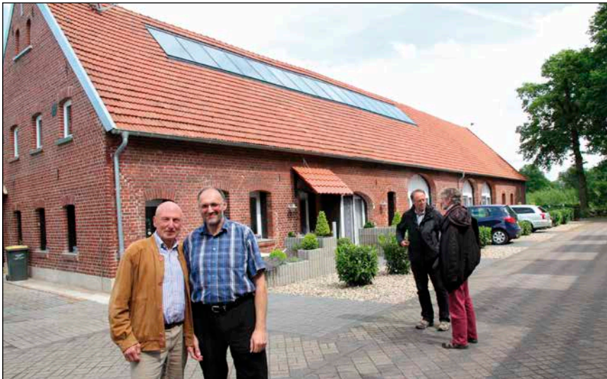
Bild 1: Hausherr Rudolf Schnieder (rechts) und DGS-Vorsitzender Dr. Peter Deininger. Im Hintergrund der ehemalige Sauenstall mit der ins Dach eingebauten Solarthermieanlage (40 m 2 ). Sie leistet im Sommer bis zu 40 kW.
