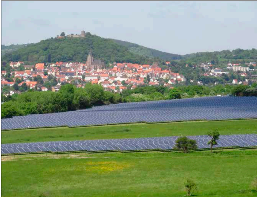
Bild 1: Solarparks in Homberg mit Modulen auf der Basis kristalliner Silizium-Wafertechnologie und einer installierten Leistung von 7,44 MW p 1)
