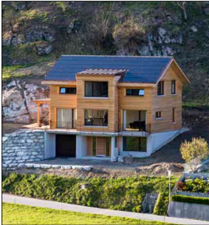
Bild 1: Einfamilienhaus in Ruschein mit ganzflächig integrierte PV-Dachanlage: Die in den Bündner Bergen gelegene Solaranlage liefert über 1.200 kWh Solarstrom pro installierte kW Leistung, während aktuelle Ökobilanzen von einem Schweizerischen Durchschnittswert von 922 kWh/kWp ausgehen. Entsprechend tiefer sind auch die Treibhausgasemissionen des Solarstroms.
