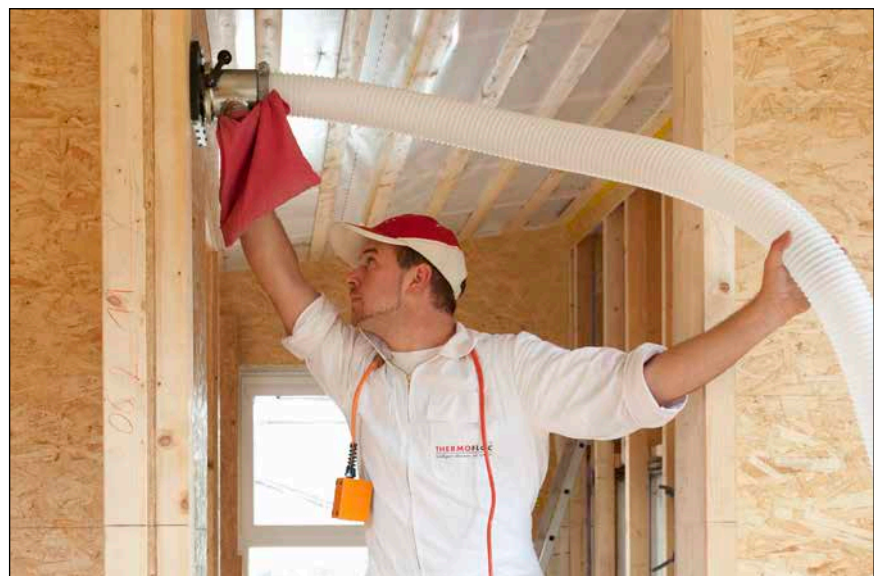
Bild 4: Ein zertifizierter Verarbeiter bringt mit Hilfe einer Verblasmaschine den Zellulosedämmstoff in das zu dämmende Bauteil ein.
