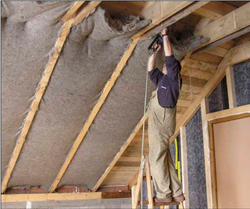
Bild 3: Die Dachsparrendämmung ist mit Dämmmatten, etwa aus Schafswolle, möglich.
