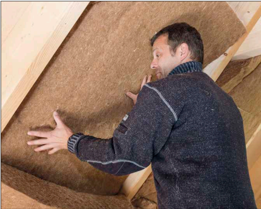
Bild 1: Matten aus Jutefasern sind in unterschiedlichsten Dämmstärken erhältlich, lassen sich leicht zuschneiden oder passgenau ab Werk beziehen.
