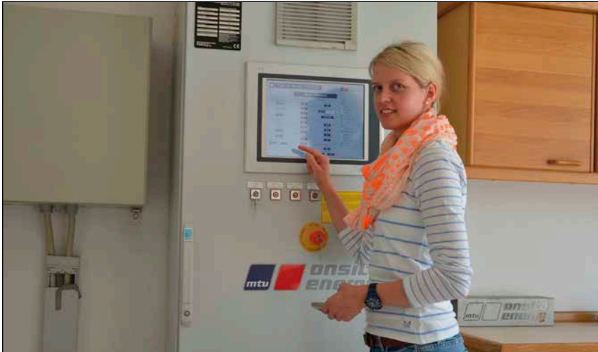
Bild 1: Mareike Lührs beim Bedienen der Biogasanlage
