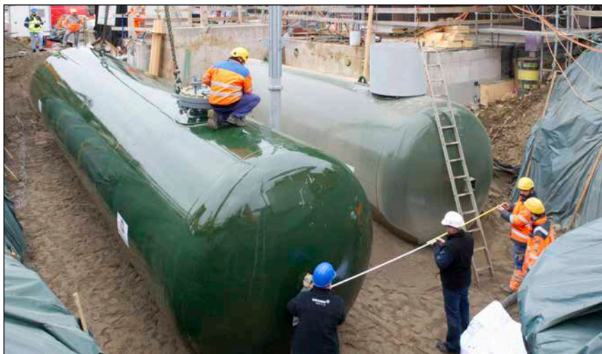
Bild 5: Brütten: Die zwei Wasserstofftanks sind erdverlegt. Der Wasserstoff wird mit einem Druck von ca. 30 bar gespeichert und in den Wintermonaten über eine Brennstoffzelle in Strom umgewandelt.
