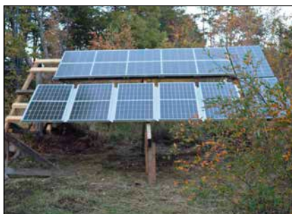
Bild 4: 5 kW PV für die Stromerzeugung
