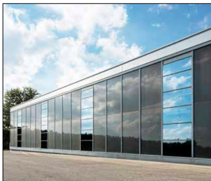
Bild 1: P/R-Fassade mit integrierten thermischen Kollektoren
