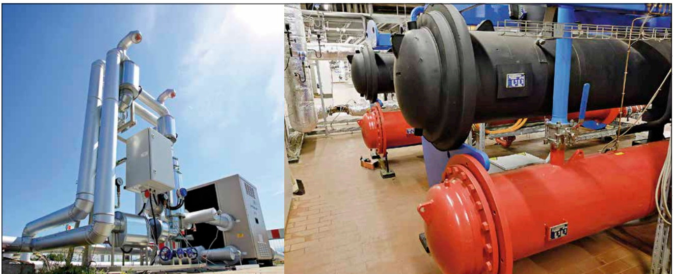
Bild 6: Die solarthermische Kühlung steht in Konkurrenz zu Systemen mit konventionell oder solarelektrisch angetriebenen Kompressionskältemaschinen. Links: Absorptionskältemaschine; rechts: Kompressionskältemaschine
