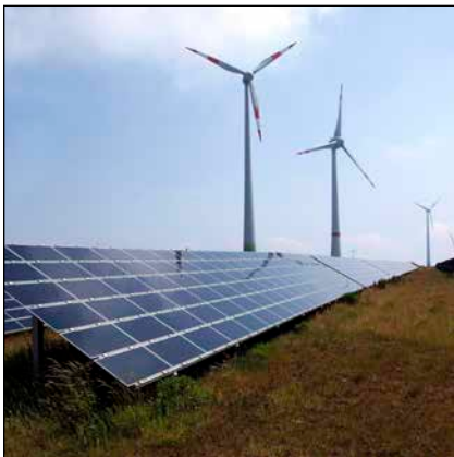
Windkraftanlagen und Photovoltaikanlagen sind die wichtigsten Energiewandler einer zukünftigen regenerativen Stromerzeugung
