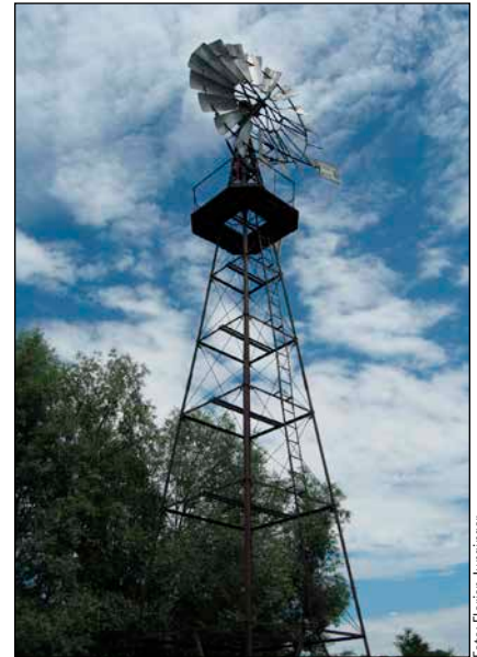
Bild 5: Western-Windrad zur Förderung des Grundwassers
