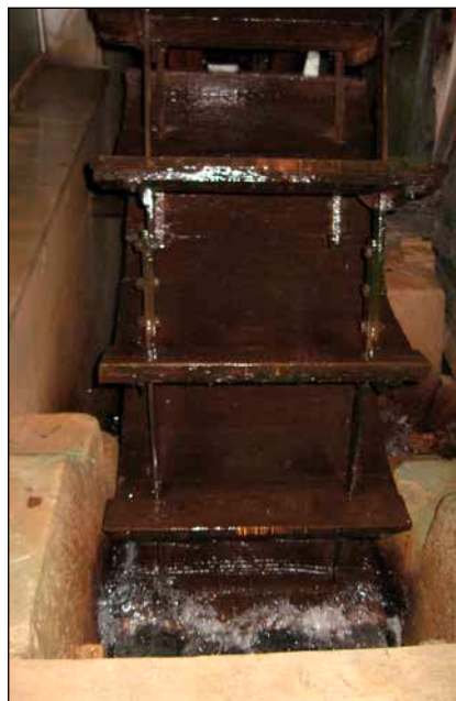
Bild 7: Zulauf zum mittelschlächtigen Wasserrad der „Aumühle“
