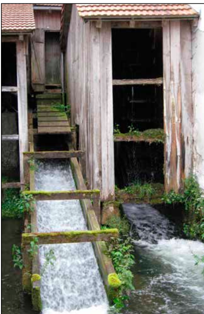
Bild 6: Abfluss aus dem Wasserrad der „Aumühle“
