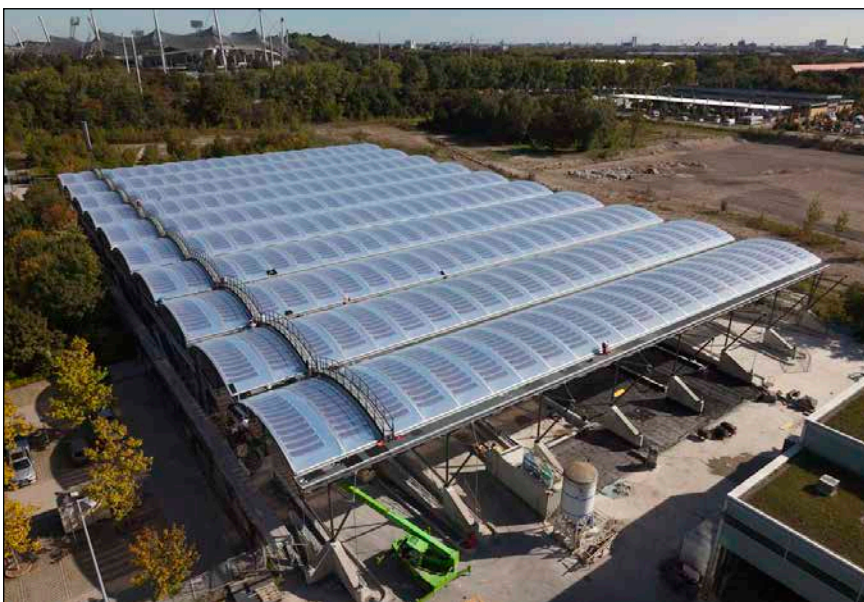
Bild 2: München, Überdachung des Carports des Abfallwirtschaftsamts (2011)
