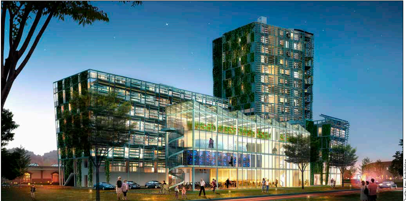
Bild 1: Der Smart Green Tower ist ein Wohn- und Gewerbeturm. Im Verband mit weiteren intelligenten Objekten soll er in einem intelligenten Netz arbeiten und die Basis für neuartige Stadtteilkonzepte bilden.
