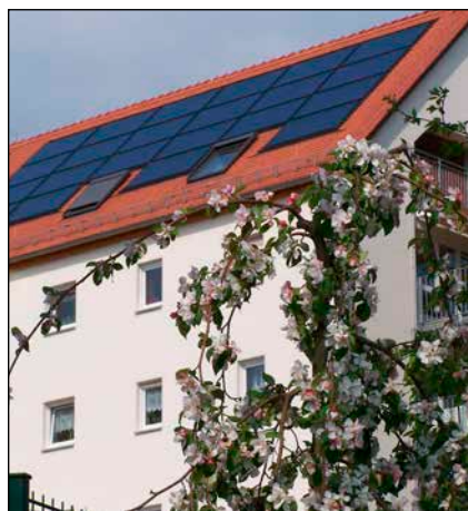
Bild 4: Dachintegrierte Solarthermieanlage Kastanienhof
