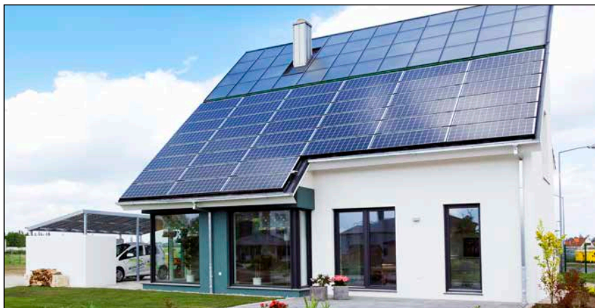
Bild 3: Das Energieautarke Haus. Mit Solarthermie, Photovoltaik, Wärme und Strom speichern sowie Elektromobilität
