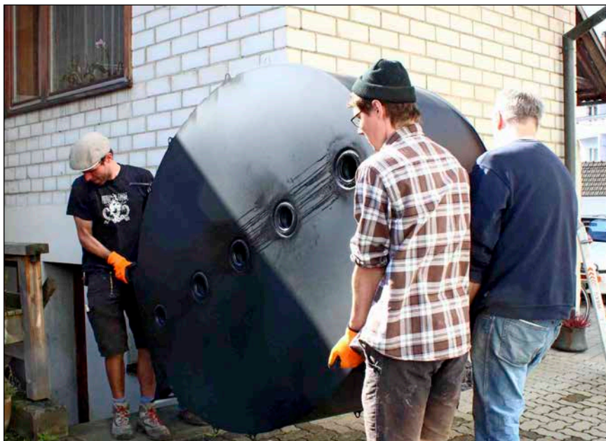
Bild 3: Innovationspreisträger Solarthermie 2017: Wärmespeicher Vartical bei der Einbringen durch einen engen Kellerzugang
