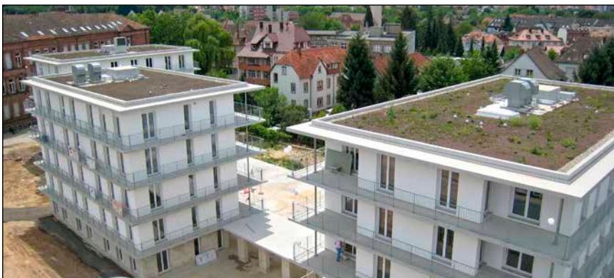
Bild 1: Ansicht der drei Mehrfamilienhäuser mit je acht bis achtzehn Wohneinheiten; die Luft-Wärmepumpen befinden sich auf dem Dach
