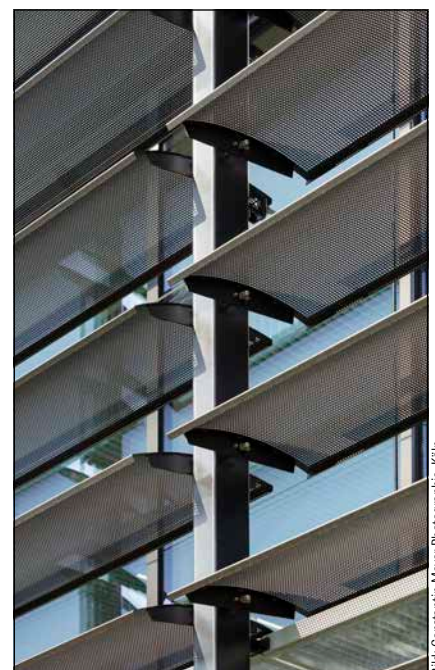
Bild 2: Semitransparenter Lamellen-Vorhang als Wärmeschild an der Ostfassade
