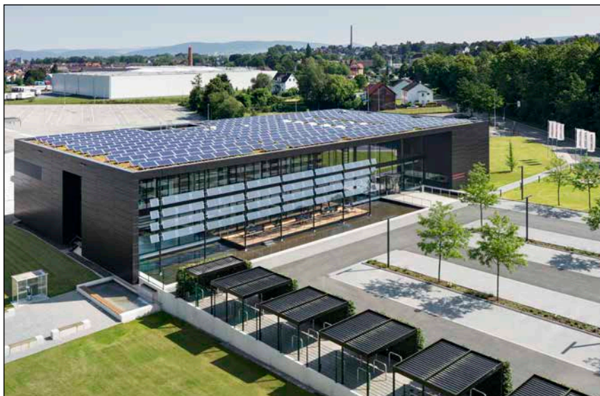
Bild 3: Blick vom angrenzenden Stiebel Bürogebäude auf den Energy Campus. PV-Technik dominiert Dach wie Südfassade.
