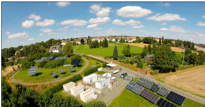
Blick auf das Photovoltaik-Testfeld des ZAE Bayern im oberfränkischen Arzberg
