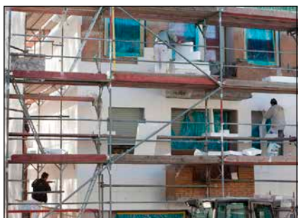
Bild 2: Fassadendämmung in Berlin-Hakenfelde, Kornburger Weg
