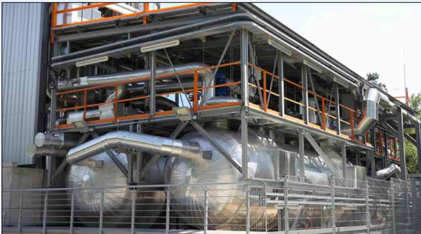
Bild 3: Die Anlage ist so konzipiert, dass sich die Salzmassenströme und ihre Temperaturen je nach Testanforderungen differenziert regeln lassen
