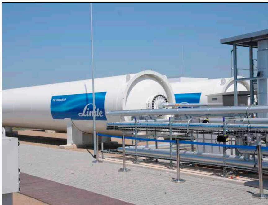
Bild 2: Zur Zwischenlagerung des in Mainz erzeugten Wasserstoffs stehen zwei Speicherbehälter mit je 82 m 3 bereit.
