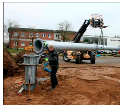
Bild 3: Wenn der Fuß fest im Erdreich verankert ist, wird der Stahlurm montiert.
