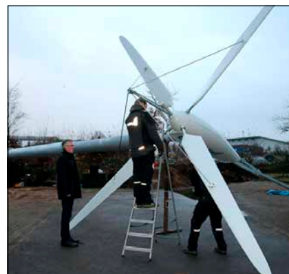
Bild 4: Der Rotorkopf der Kleinwindanlage wird am Boden auf den Turm montiert. Anschließend wird der Turm hochgezogen und am Fuß verschraubt.
