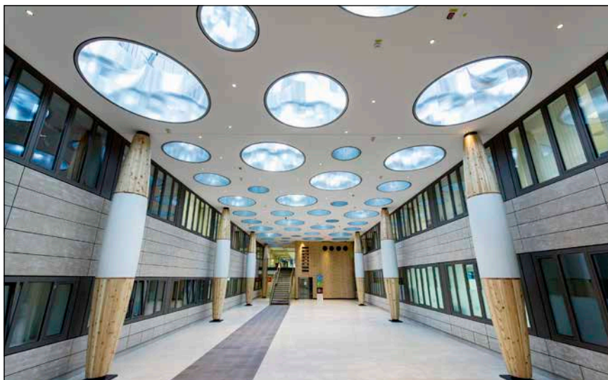
Bild 1: Im Klinikum Garmisch-Partenkirchen werden 49 unterschiedlich große Oberlichter in einem Neubau aus dem Jahr 2016 durch Tageslichtrohre versorgt. Das Licht wird dabei durch eine hochreflektierende, eloxierte Aluminiumoberfläche in den Raum geleitet. Das Beleuchtungskonzept dafür erstellte Bartenbach Lighting Design aus Aldrans in Tirol.
