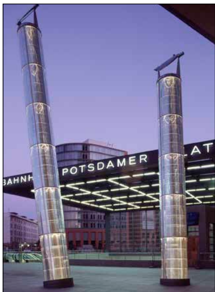
Bild 3: Die „Light Pipes“ am Bahnhof Potsdamer Platz lenken auf auffällige Weise Tageslicht ins Untergeschoss.
