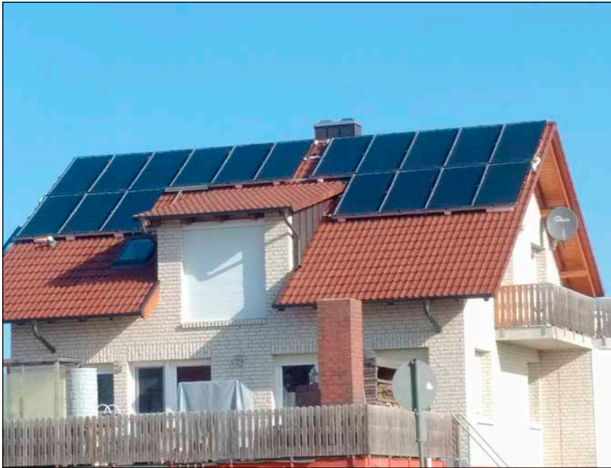
Bild 1: Viele alte PV-Anlagen stehen bald vor der Frage, wie es weitergeht.
