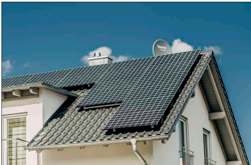
Bild 2: Beispiel einer Anlage mit „normalen“ Black-Modulen, bei denen die weiße Rückseitenfolie durchschimmert
