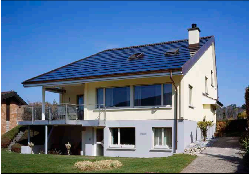
Bild 1: Umbau eines Einfamilienhauses mit solarer Ganzdachlösung in der Nähe von Basel. Bei der Installation des Solrif-Indachsystems mussten zwei Dachfenster und der Kamin in die Solarfläche integriert werden.
