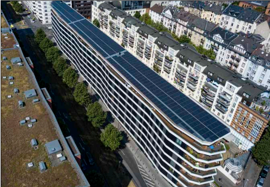
Dachaufsicht des „Aktiv-Stadthaus“ der ABG in Frankfurt a.M. mit 74 Wohnungen
