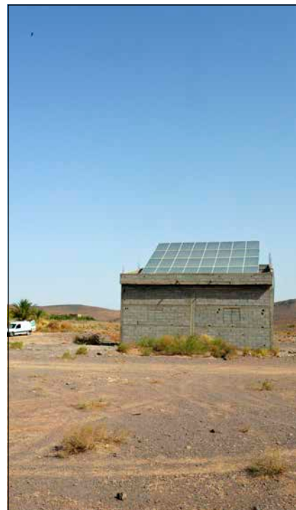
Bild 2: Photovoltaik-Module auf dem Dach einer Pumpstation für Wasser
