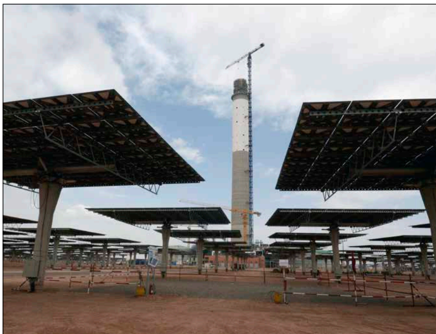
Bild 1: Baustelle des Solarturmkraftwerkes Noor III in Ouarzazarte
