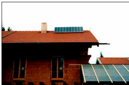
Bild 2: 1988 – ursprünglicher Solargenerator mit 500 Wp aus 10 Modulen vom Tollwood
