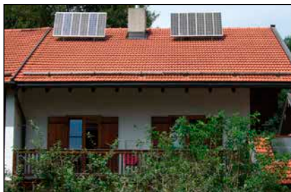
Bild 3: 1990 – Erweiterung des Solargenerators auf 600 Wp mit nun zwei mal sechs Modulen
