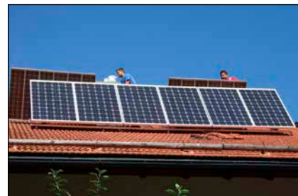
Bild 4: 2011 – Montage des neuen Solargenerators mit 1.500 Wp und Rückbau der Altanlage
