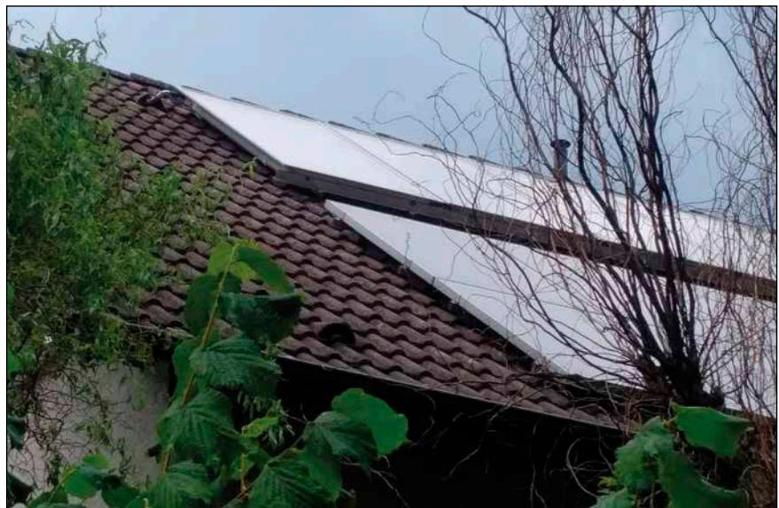
Bild 2: Photovoltaik und Solarthermie auf dem Dach
