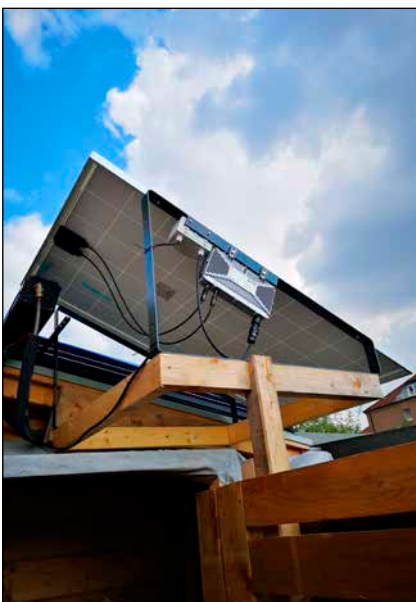
PV-Modul mit Mikrowechselrichter
