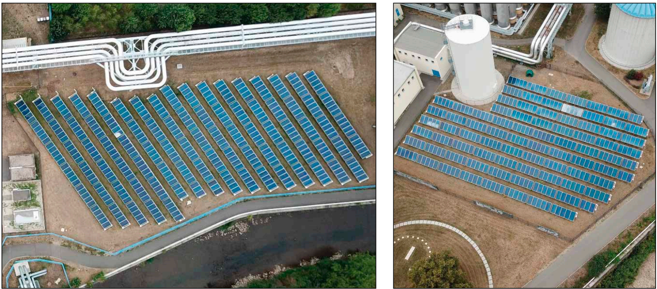
Bild 1: Luftaufnahmen des Nordfeldes (links) und Südfeldes (rechts), Freilandaufständerung
