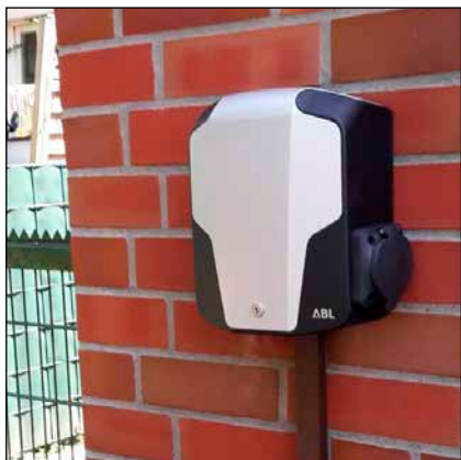
Bild 2: Eine heimischen Wallbox von ABL für Ladeleistungen bis 11 kW
