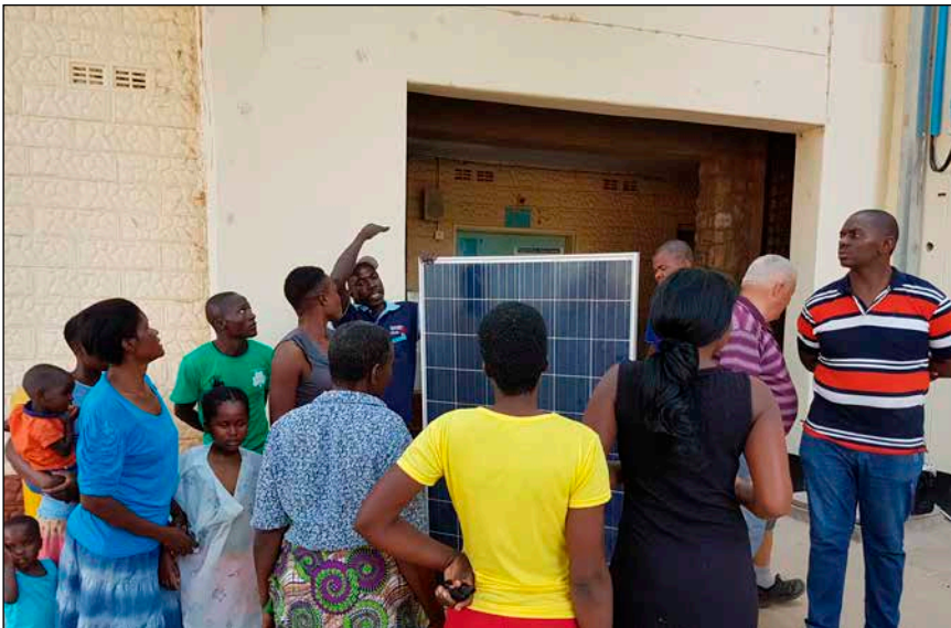
Bild 1: Elektriker Mafungwase erklärt einigen Patienten die Funktionsweise und Aufgabe der neuen Photovoltaikanlage.
